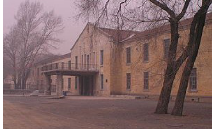
یکی از ساختمان های متعلق به واحد ۷۳۱
